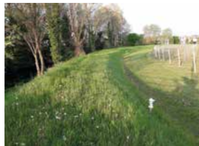
Nuovi argini sul torrente Favero in corrispondenza di via Cavalieri di Vittorio Veneto a Vissnà con il Consorzio di Bonifica Piave
