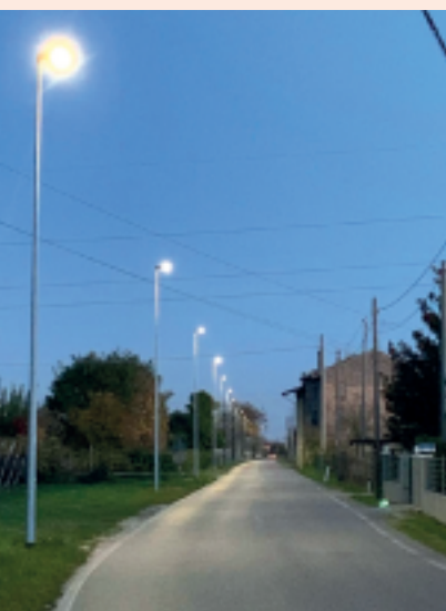
Impianto realizzato in via Cal di Mezzo
